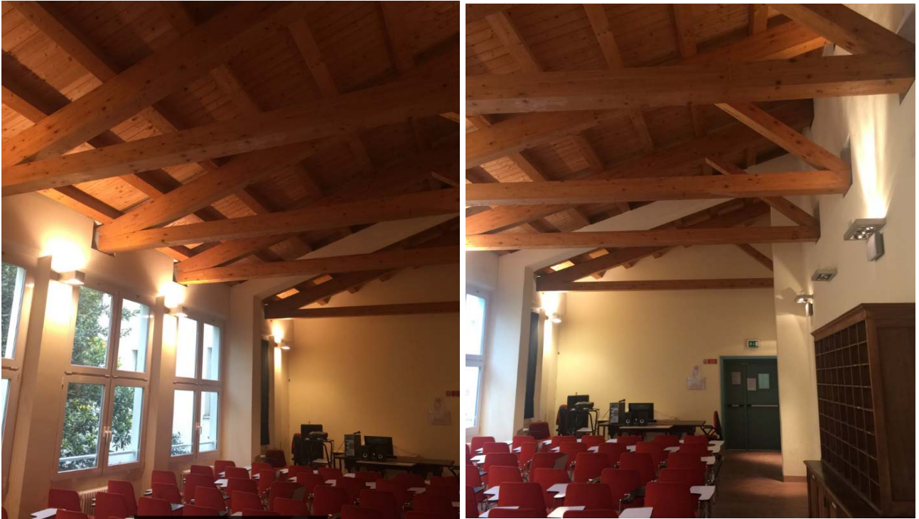
Copertura con capriate in legno che poggiano su cordolo in c.a. del Corpo C
